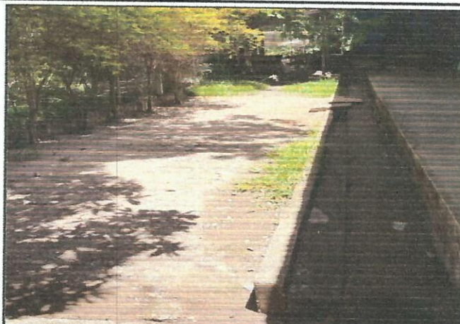
Foto 2: Mejoramiento en el area del corredor de la escuela con torta de cemento.
